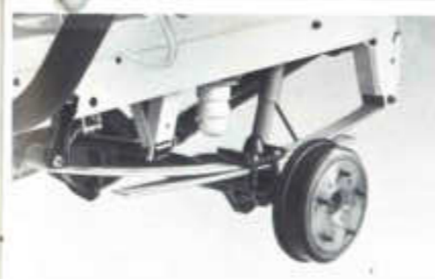
Die Längsblattfeder hinten und die Gummihohlfeder.
